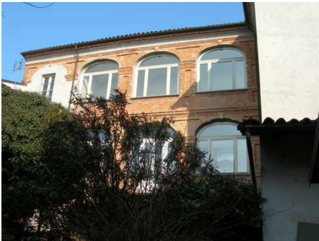
FOTO 3: Facciata Sud del Palazzo Municipale; sostituzione degli infissi ala piano primo, inoltre i serramenti di tipologia ad arco dovranno essere rimpiazzati con una tipologia di serramenti a triplo vetro
