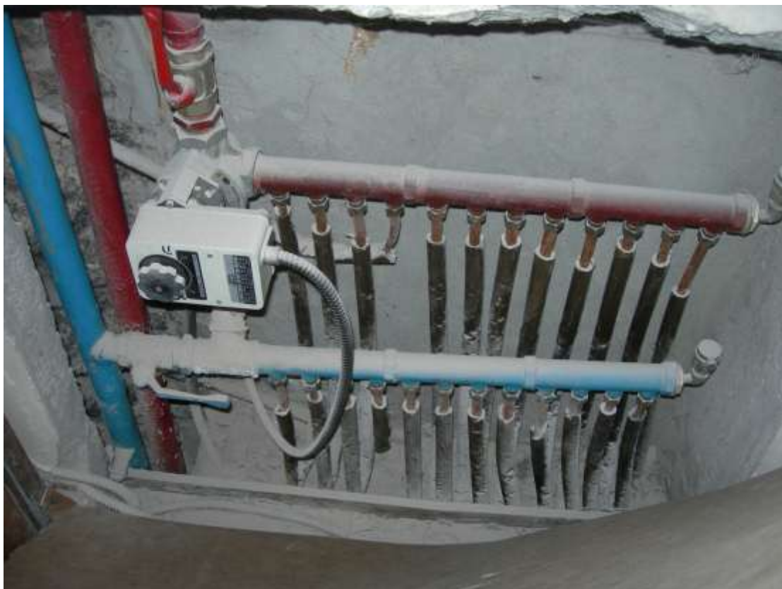
FOTO 13: Piano primo Palazzo Municipale; collettori da sostituire
