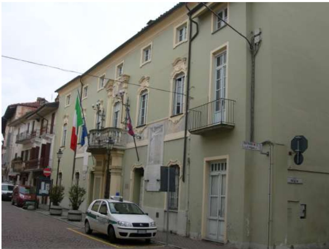
FOTO 1: Facciata Nord Palazzo Municipale; sostituzione degli infissi al piano primo e restauro del portone principale centrale al piano terra
