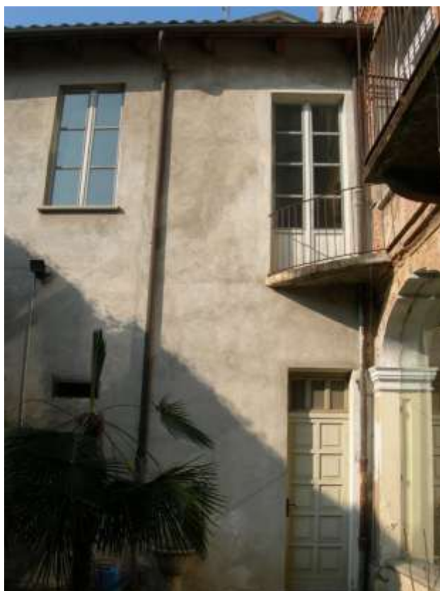
FOTO 4: Facciata Est cortile interno del Palazzo Municipale; sostituzione porta-finestra e finestra del piano primo e risanamento del balcone ad arco nell'angolo
