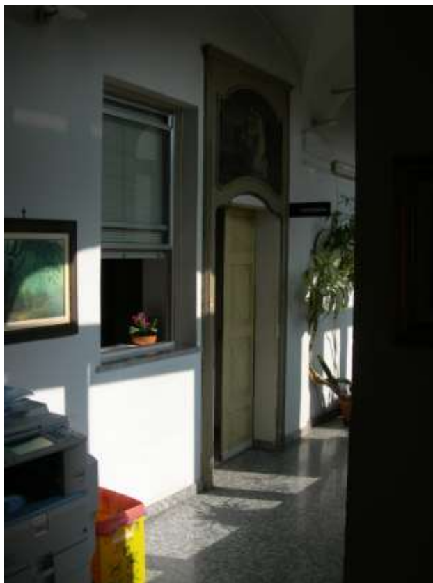
FOTO 9: Piano primo Palazzo Municipale; porta in legno da restaurare e botteghino della Ragioneria che dovrà essere chiuso con una muratura in mattoni arretrata
