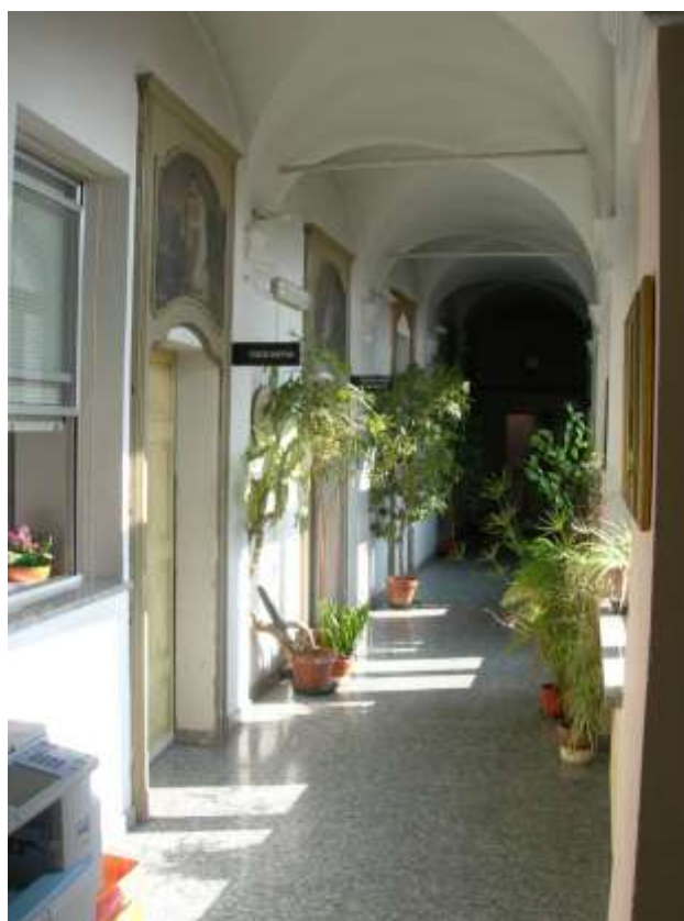
FOTO 8: Piano primo Palazzo Municipale; a sinistra porte in legno che necessitano di restauro, a destra finestre ad arco che verranno sostituite con finestre a triplo vetro
