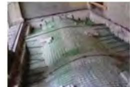
In una seconda fase è previsto il consolidamento ed il ripristino delle murature di scarico degli archi e delle volte, tramite svellimento dei blocchi di pietra e sarcitura con rete e betoncino oppure sigillatura con malta di cemento.
