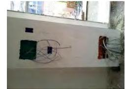
Si procede, con le modalità di aggancio dei capicorda dei conduttori al cavo pilota ed immissione nei canali sottotraccia, a stendere tutti i cavi fino a completamento di tutti i tracciati interni ed esterni degli appartamenti.
