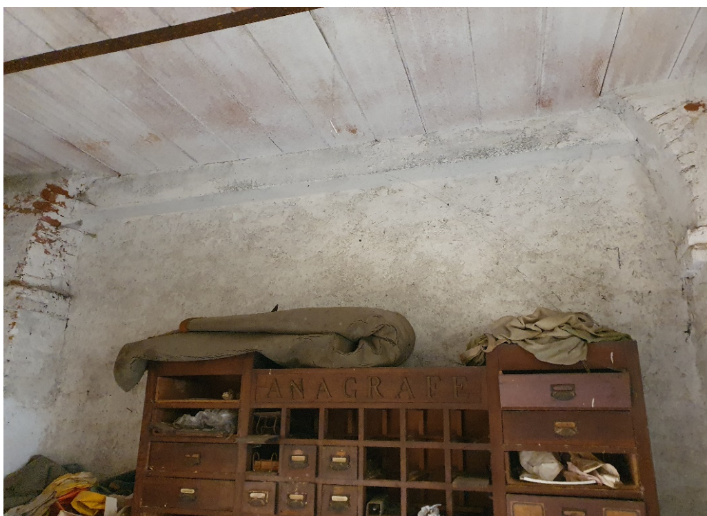
Fig. – Muratura oggetto di parziale demolizione
