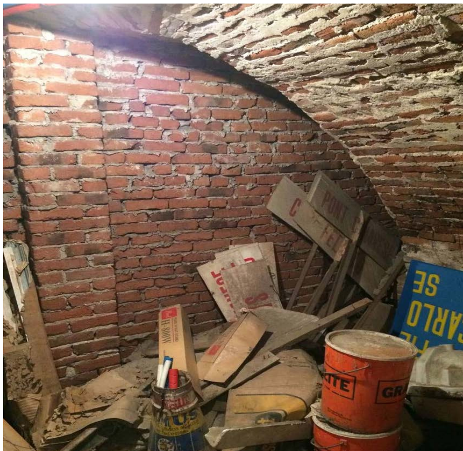
Fig. – Muratura oggetto di parziale demolizione
