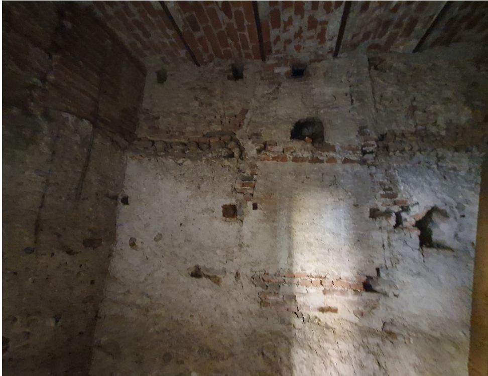
Fig. – Muratura oggetto di parziale demolizione
